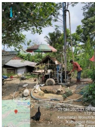
Gambar 4. Proses Pengeboran Sumur Bor
