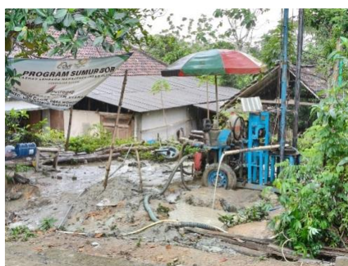
Gambar 5. Proses Pemasangan Pipa
