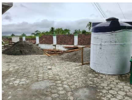
Gambar 1. Alat dan Bahan Pembangunan Sumur Bor
