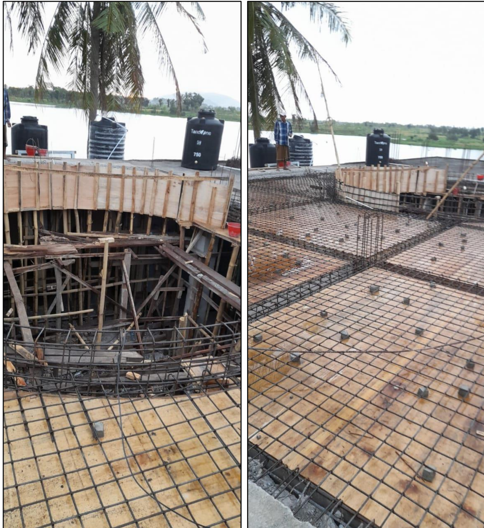
Gambar 5. Pembesian plat dag dan dudukan kubah masjid
