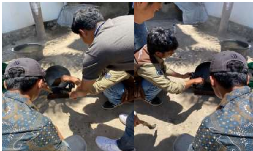
Gambar 4. Proses Pencetakan Paving Blok
